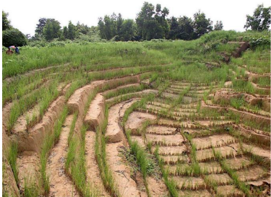
Figura 8.3 – Recuperação de ravinamento com capim vetiver no Congo. (Fonte: Elder Madruga).
