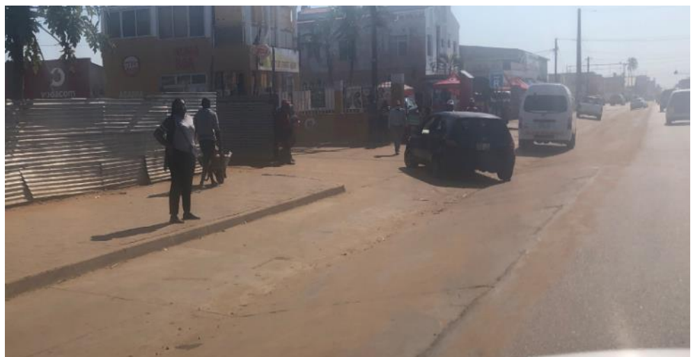
Figura 6.33 – Valeta de betão de grandes dimensões e usada como estacionamento
