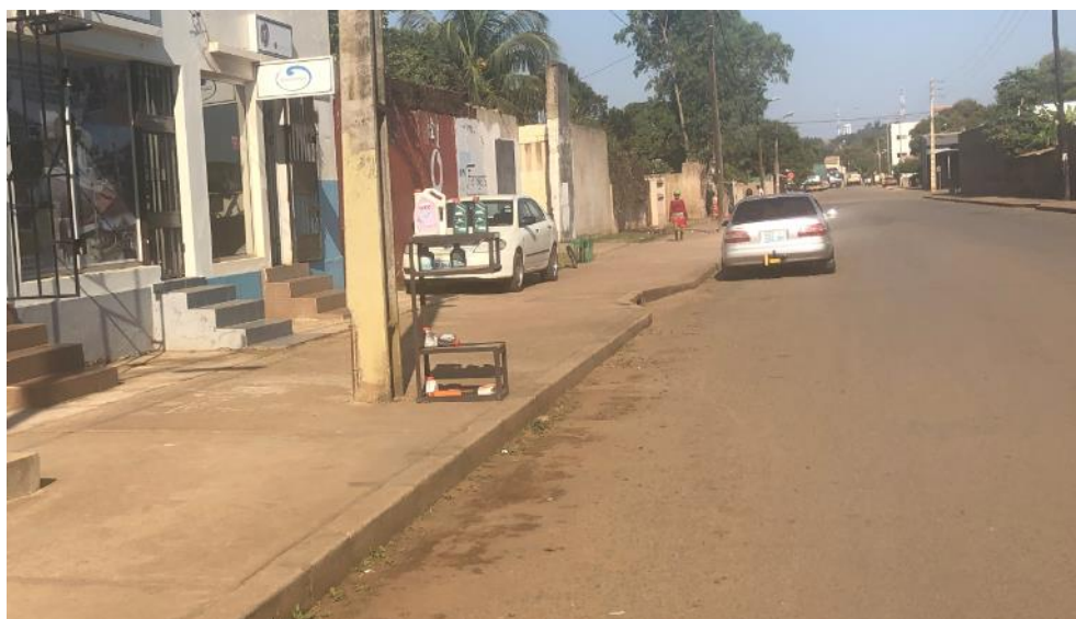
Figura 6.28 – Via no centro com revestimento betuminoso e drenagem bem definida
