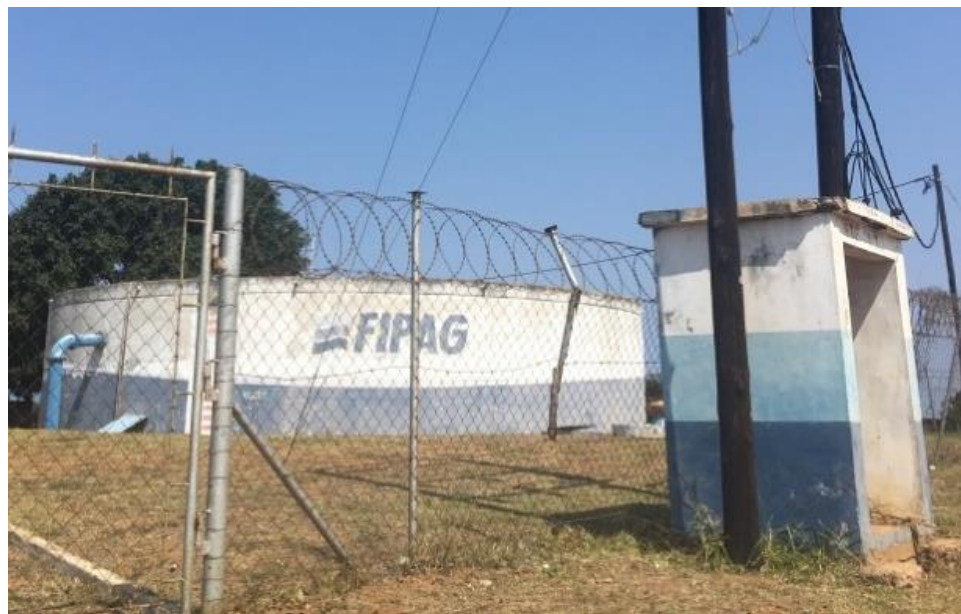
Figura 6.16 – Reservatório semienterrado
