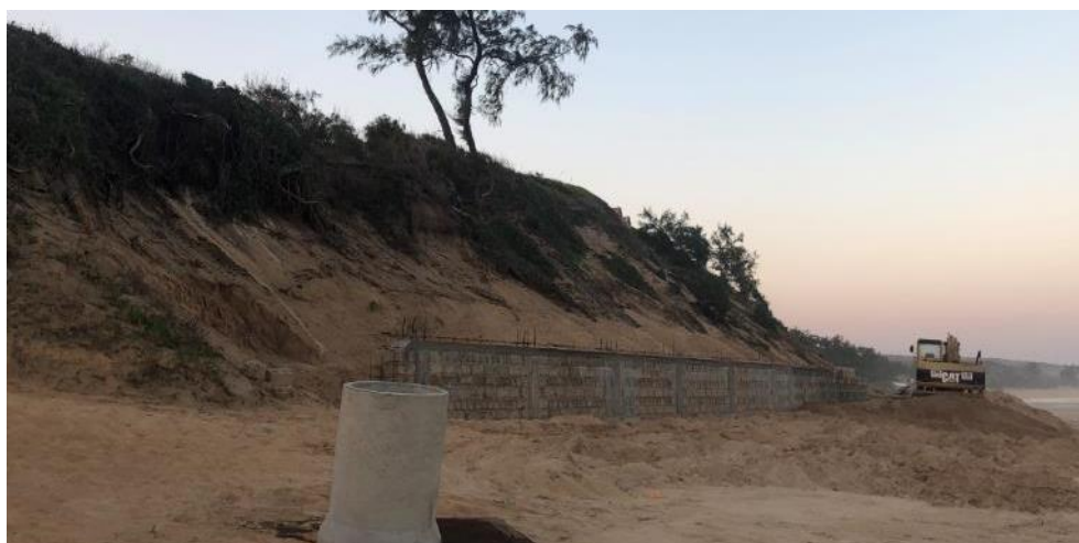
Figura 6.24 – Obras em curso para conter um ravinamento
