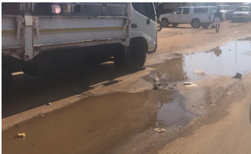
Figura 6.35 – Acumulação de água em zonas muito planas
