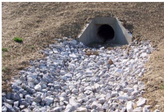
Figura 8.4 – Exemplo de bacia de dissipação em enrocamento.
