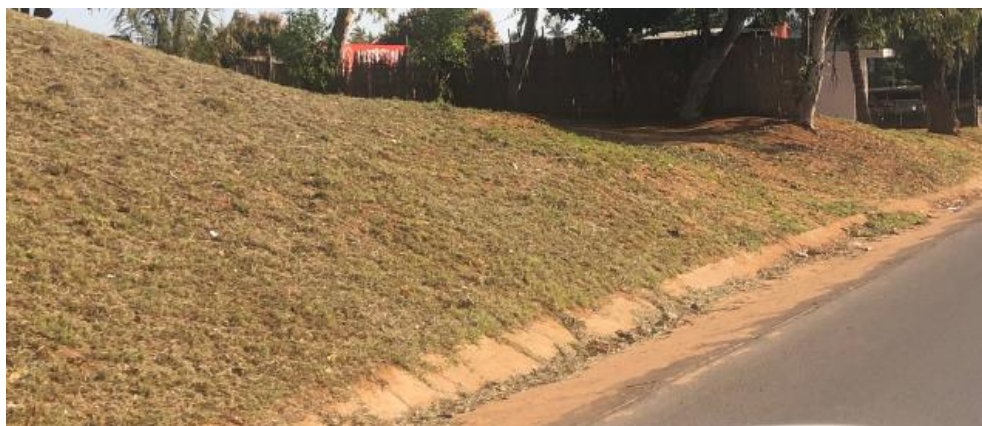
Figura 6.34 – Valeta de betão em trecho de escavação
