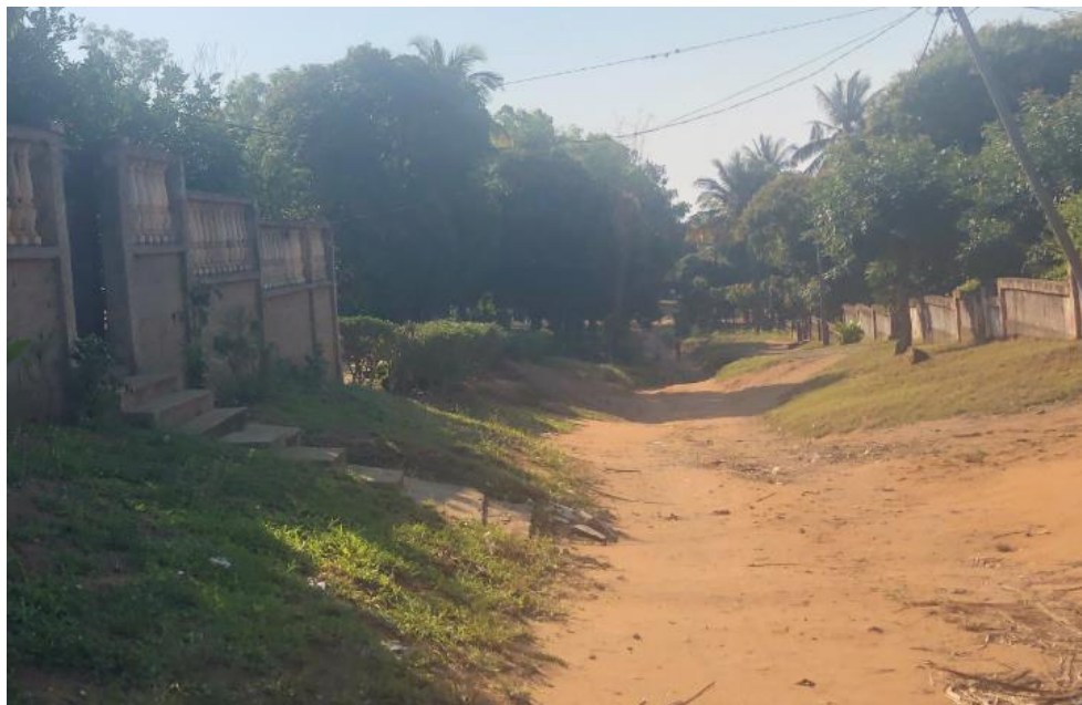
Figura 6.20 – Estrada de terra em linha de água. Perda de solo evidente.
