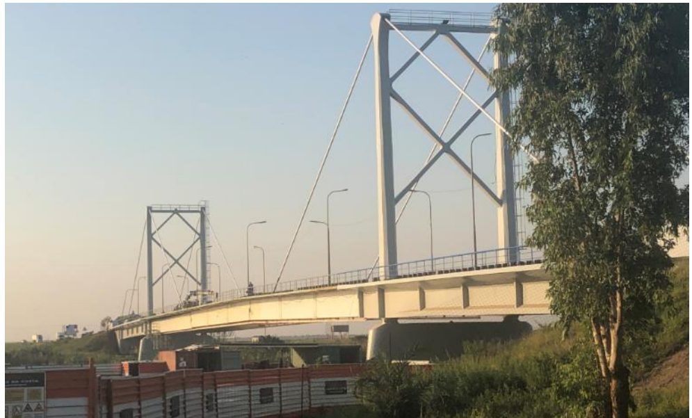
Figura 6.37 – Ponte sobre o Rio Limpopo, na EN1
