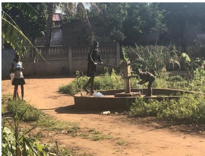
Figura 6.17 –Furo de captação e de um ponto de água com bombagem manual identificados em campo
